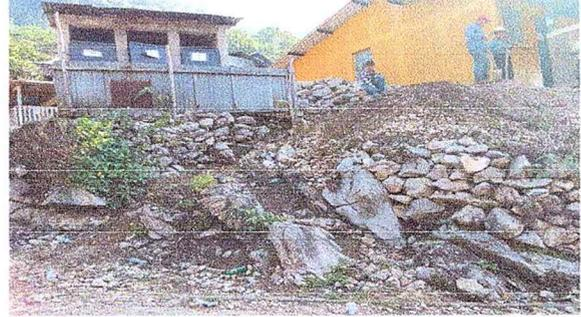
Foto 1.1. Reparación de muros de contención del aula multigrado, complemento de la foto 1, el edificio esolar está en peligro por derrumbe y necesita remodelación.
